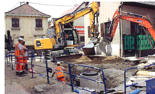
Enfouissement des réseaux secs
