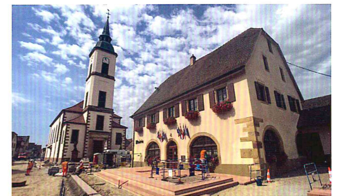
Mise en place de nouveaux pavés devant la Mairie
