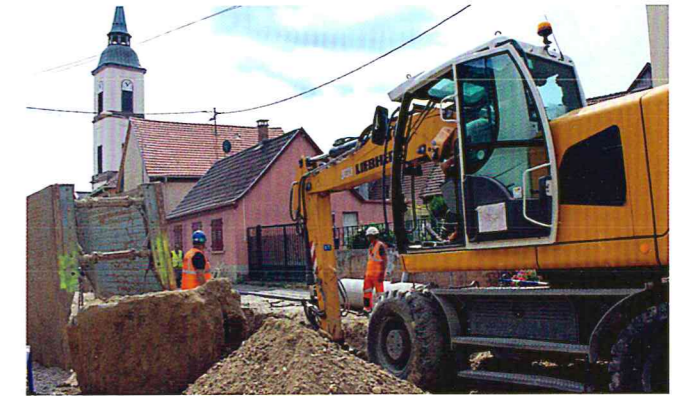
Renouvellement du réseau d'assainissement
