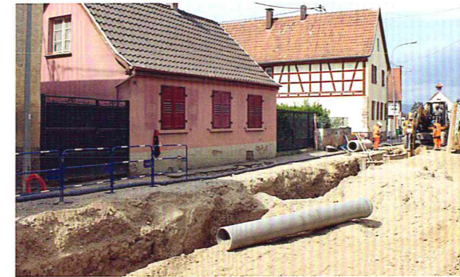
Renouvellement du réseau d'assainissement
