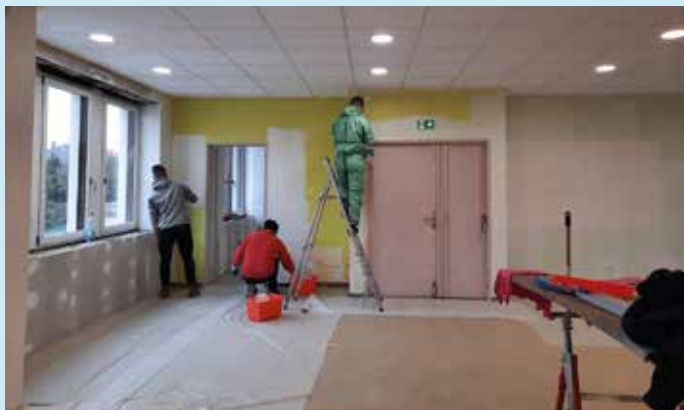
Rénovation et transformation de la salle du 1 er étage en espace coworking – 15 Grand'Rue
