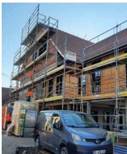
✔ Préparation de la pose du bardage – nouvelle partie de la Maison de la Santé
