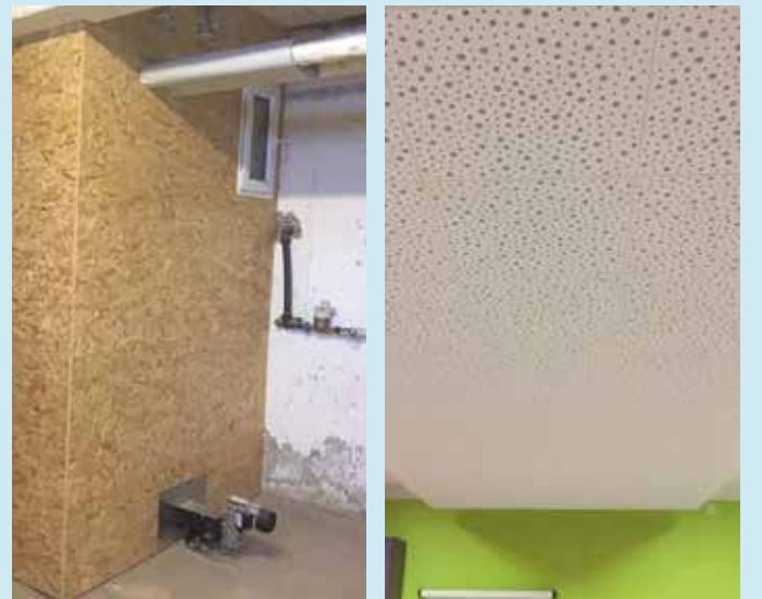
Mise en place d'un silo à pellets au groupe scolaire et insonorisation du plafond dans une salle de classe
