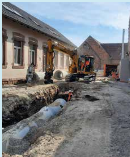
✔ Pose de canalisations pour la rétention
