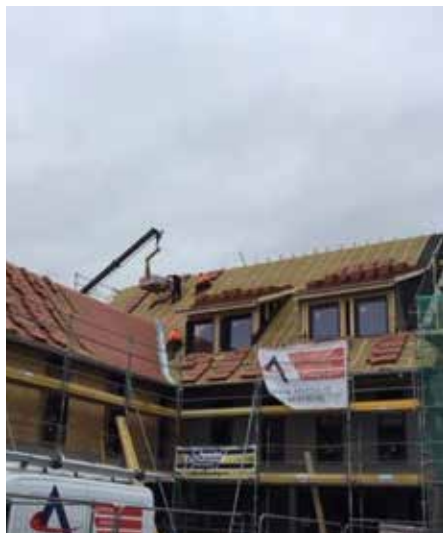
✔ Préparation de la pose du bardage – nouvelle partie de la Maison de la Santé
