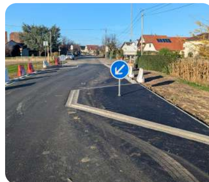
Matérialisation de places de stationnement
